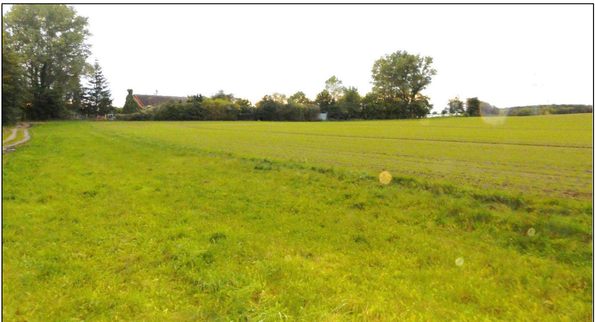
Abbildung 3: Baufeld 3 (Blickrichtung Westen)
